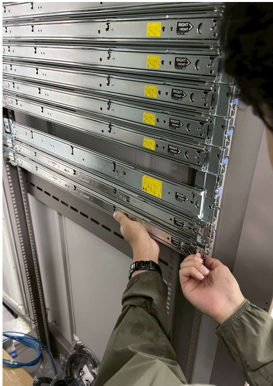
รูปที่ 2-197 การติดตั้งเครื่องคอมพิวเตอร์แม่ข่ายแบบ On Premise
